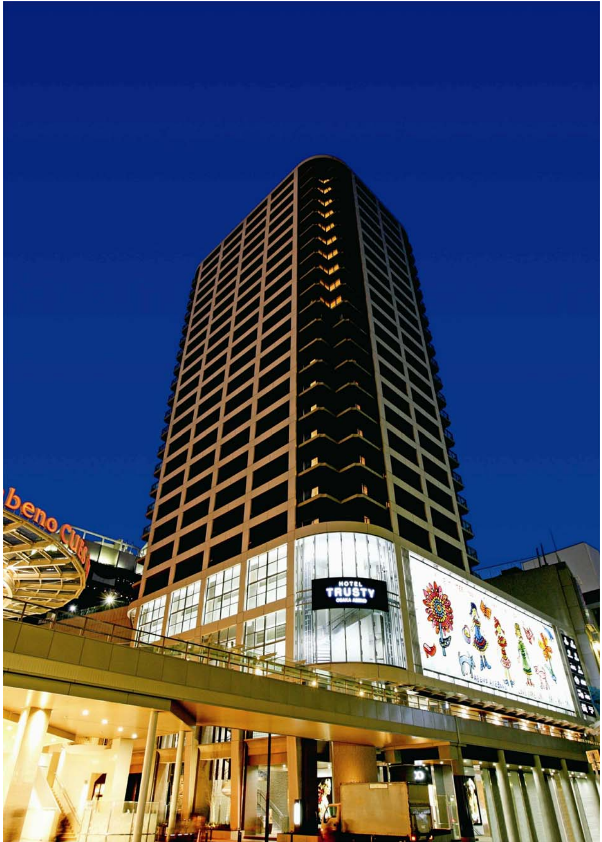
ホテルトラスティ大阪 阿倍野 外観(ホテル部分・3階～11階)
