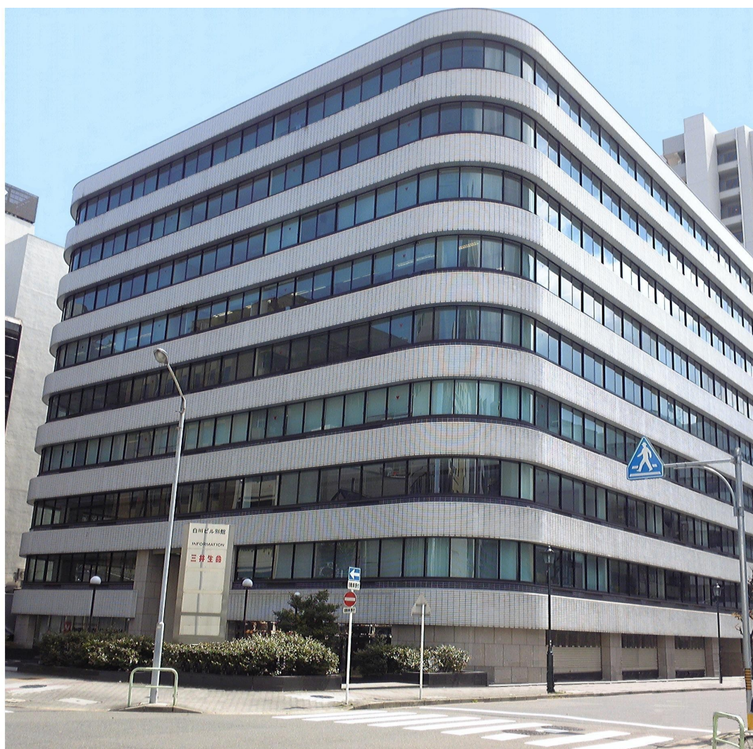
RT白川ビル(旧名称:白川ビル別館)
