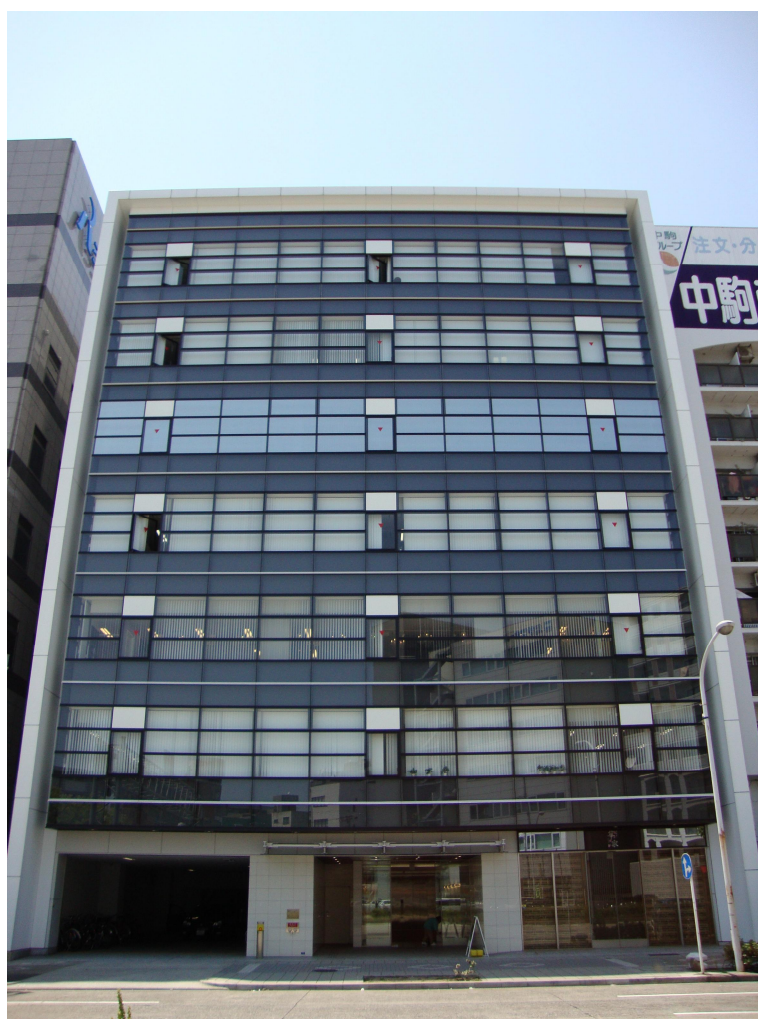
RTセンターステージビル(名古屋センターステージから名称変更)
