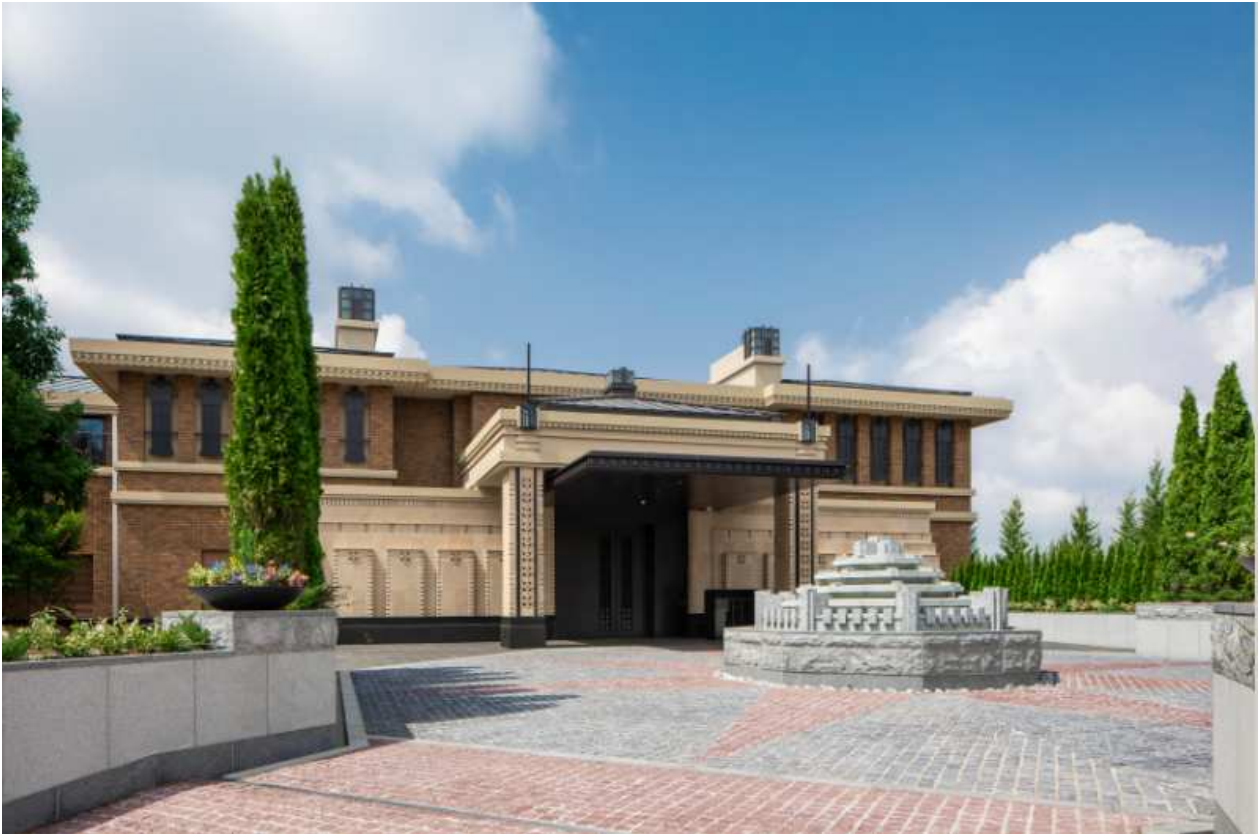
「車寄せ」より「センター棟」をのぞむ
