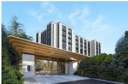
【 SANCTUARYCOURT: Total 288 rooms】
